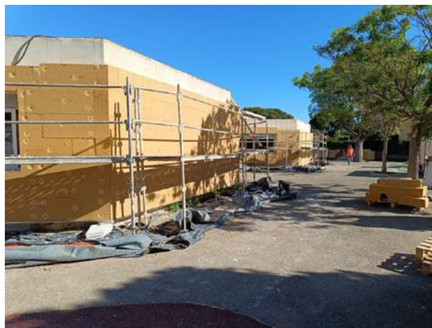
Isolation, par l'extérieur, de l'école La Buissonnière
